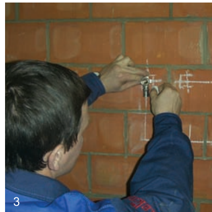
3 Намечаются места установки водорозеток
