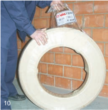
10 С бухты трубы снимаются полиэтиленовая упаковочная лента
