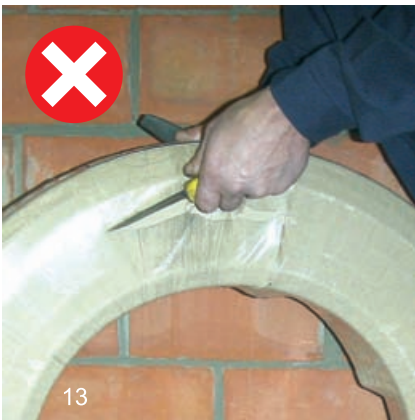
13 Разрезать упаковочные ленты ножом не рекомендуется во избежание повреждения трубы
