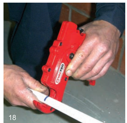
18 Отрезается требуемый кусок трубы. Это можно делать с помощью гильотинного трубореза в следующем порядке: –труба помещается в опорную скобу трубореза;
