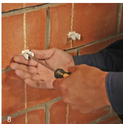
8 Устанавливаются подвижные опоры
