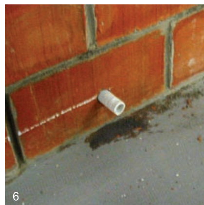
6 Устанавливаются гильзы из гофрированной трубы в отверстия стен и перегородок так, чтобы гильза выступала не менее, чем на 50 мм за грань конструкции
