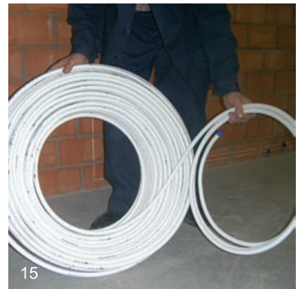
15 Отматывается необходимое количество трубы
