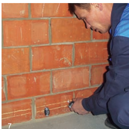
7 Устанавливаются неподвижные опоры
