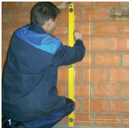
1 Разметка трассы трубопровода
