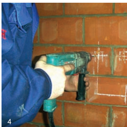
4 Высверливаются гнезда для крепления опор и водорозеток
