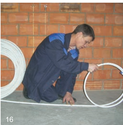
16 Вручную распрямляется отмотанный участок трубы
